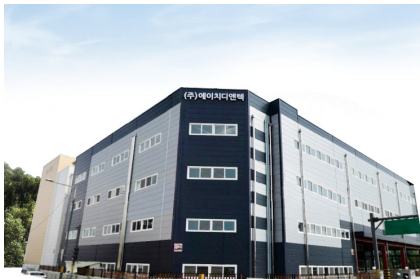
김포 제 2 공장 전경 [ 김포골드밸리내 ]
