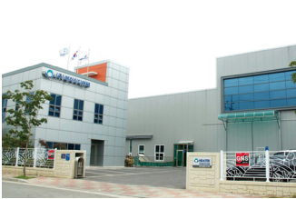
김포 제 1 공장 전경 [김포골드밸리내]
